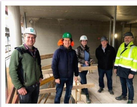
Baubesprechung mit Rundgang über die Baustelle
