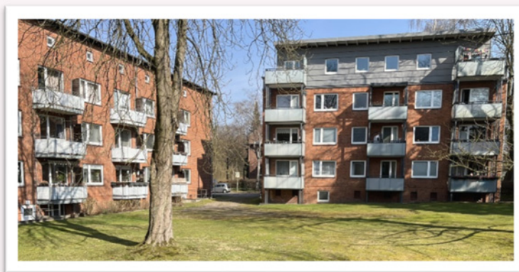
Balkone: Ahrensburger Straße (links) Birtstraße (rechts)
